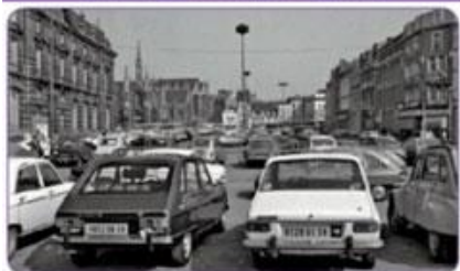
REAMÉNAGEMENT DE LA GRAND PLACE DE ROUBAIX
