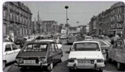
REAMÉNAGEMENT DE LA GRAND PLACE DE ROUBAIX
